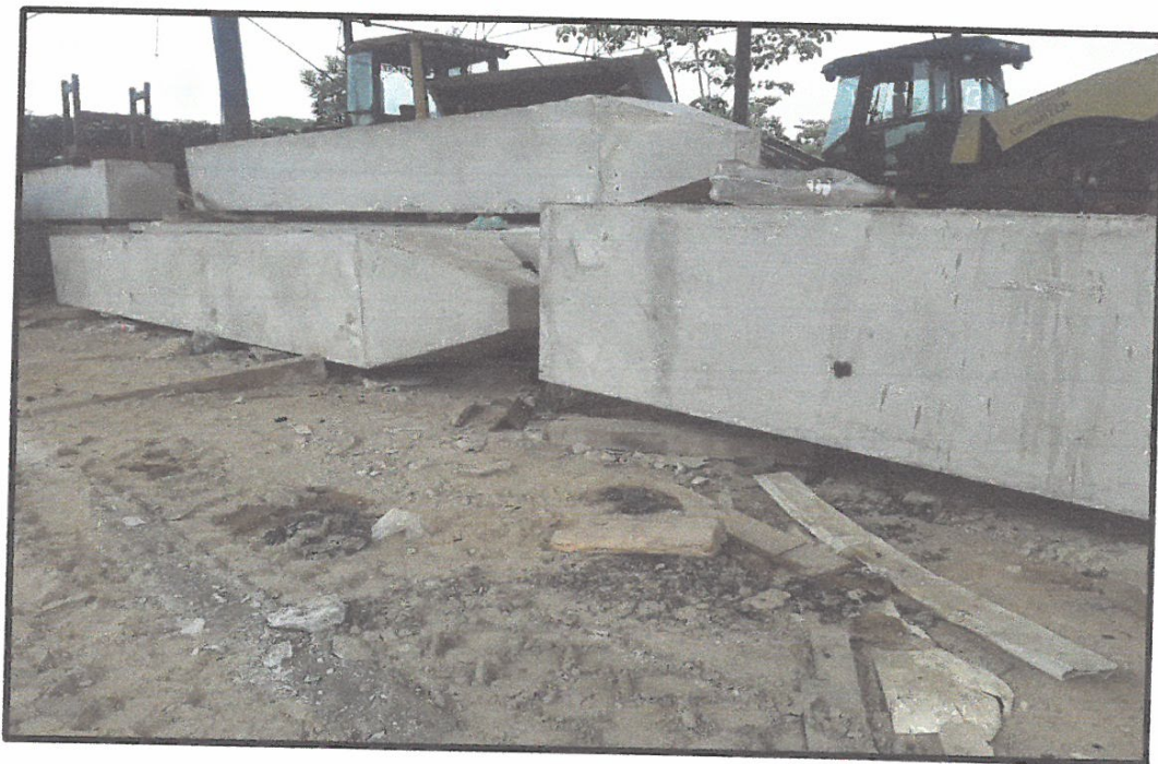
PILOTES DE CONCRETO ARMADO EN OBRA.
