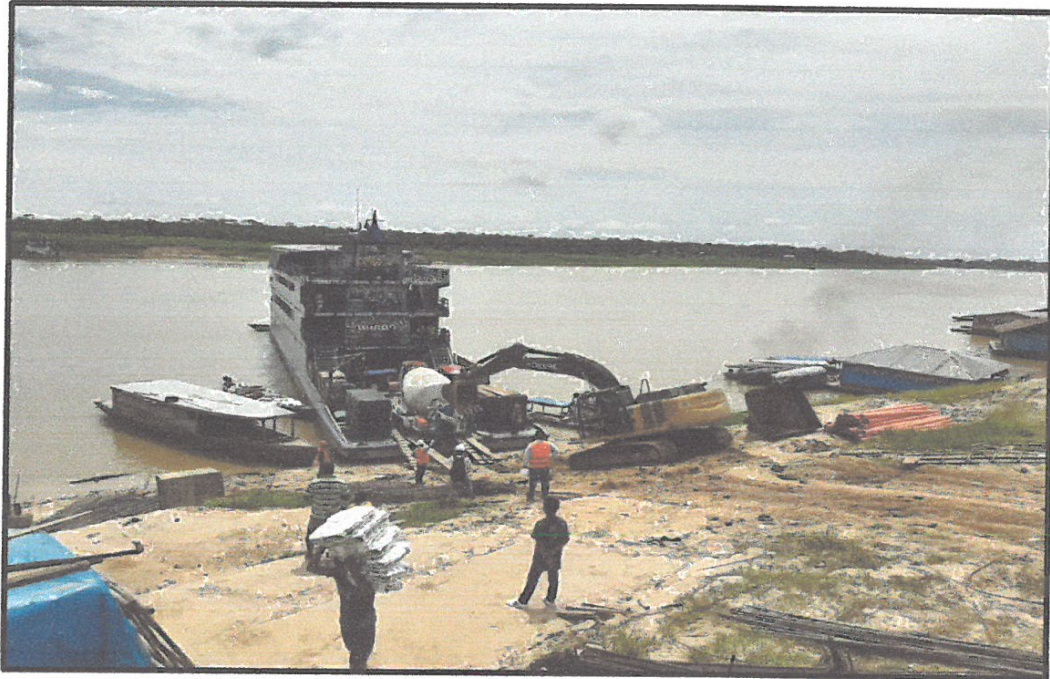
DESCARGUE DE MAQUINARIA MESCALDORA EN PUERTO PRINCIPAL DE ISLANDIA, PARA LOS TRABAJOS DE VACIADO DE MORTERO.
