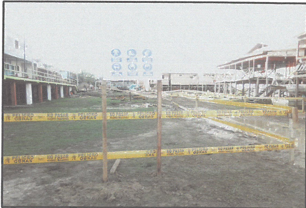
COLOCACION DE CINTA DE SEGURIDAD EN OBRA.
