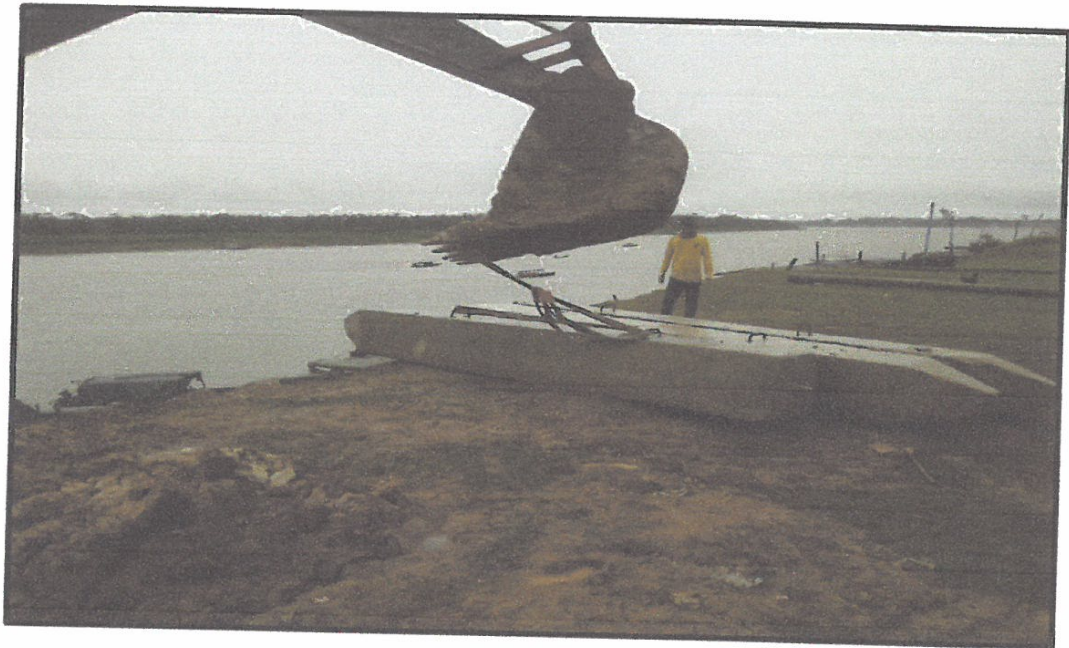
DESCARGUE DE PILOTES E CONCRETO ARMADO PARA LOS TRABAJOS DE INCADO DE PILOTES EN OBRA.
