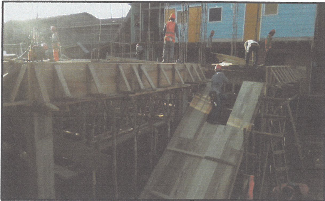
ENCOFRADO EN LOSA ALIGERADA.
