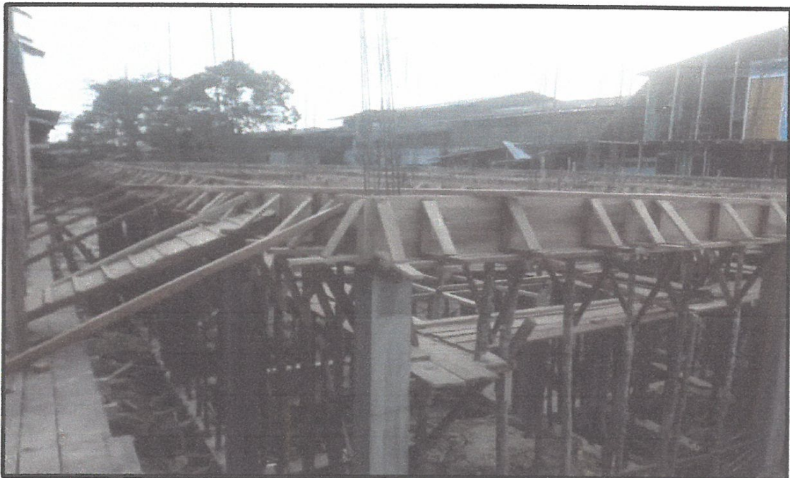
ENCOFRADO DE VIGAS Y ENCOFRADO DE LOSA ALIGERADA.
