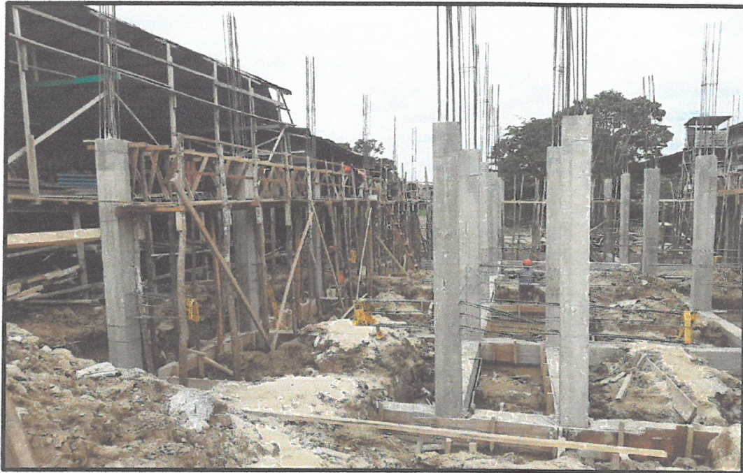
COLUMNAS DE MORTERO ARMADO EN CONTINGENCIA.
