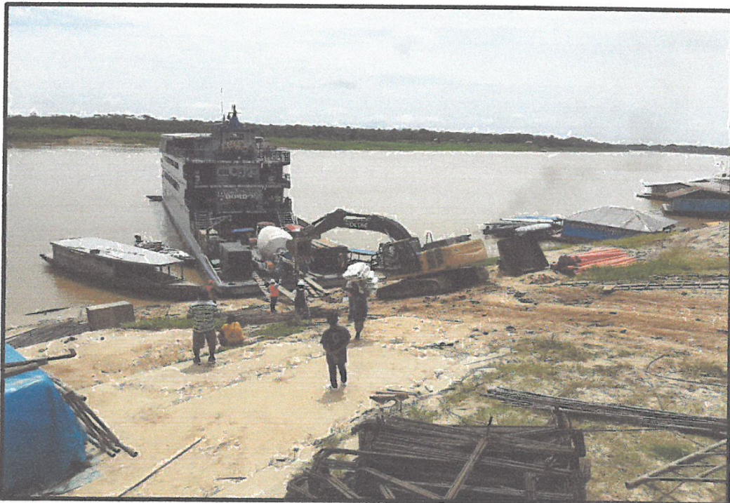
DESCARGUE DE MAQUINARIA MESCALDORA, ACERO HABILITADO EN PUERTO PRINCIPAL DE ISLANDIA, PARA LOS TRABAJOS DE VACIADO DE MORTERO.
