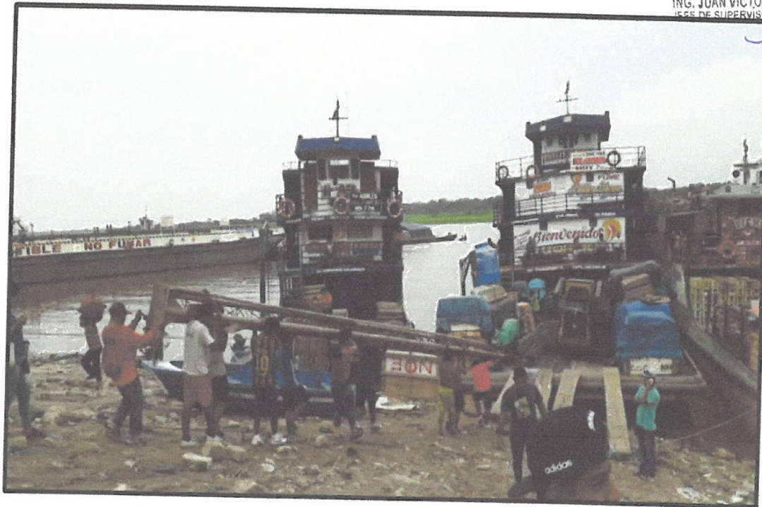
ENVIO DE MATERIALES DE CONSTRUCCION DESDE PUERTO DE IQUITOS (VIA FLUVIAL) HASTA LA LOCALIDAD DE ISLANDIA.
