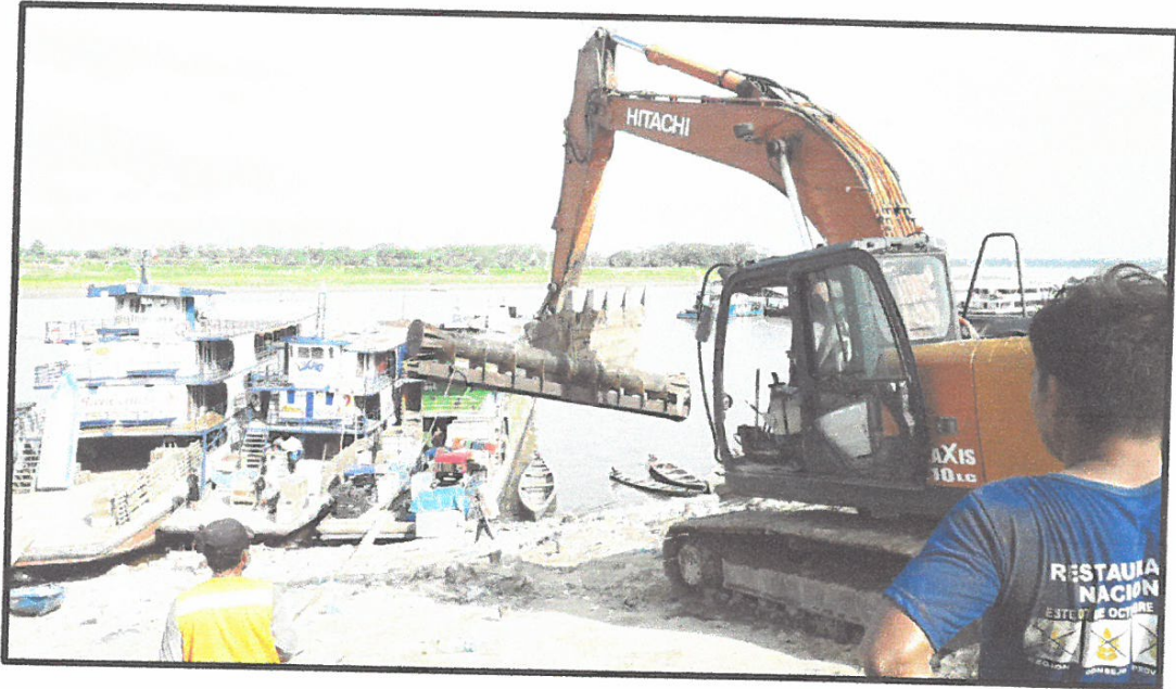
ENVIO DE MAQUINARIAS, HERRAMIENTAS Y MATERIALES DE CONSTRUCCION, A LA LOCALIDAD DE ISLANDIA POR VIA FLUVIAL.
