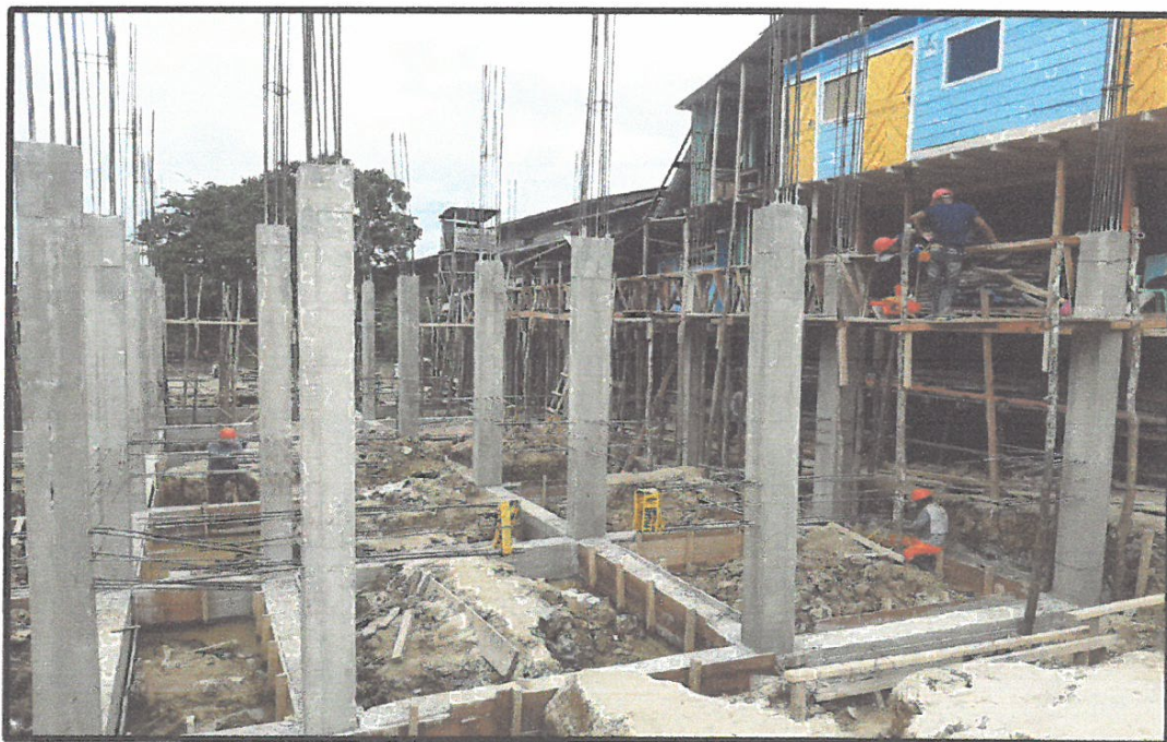
COLUMNAS DE MORTERO ARMADO EN CONTINGENCIA.
