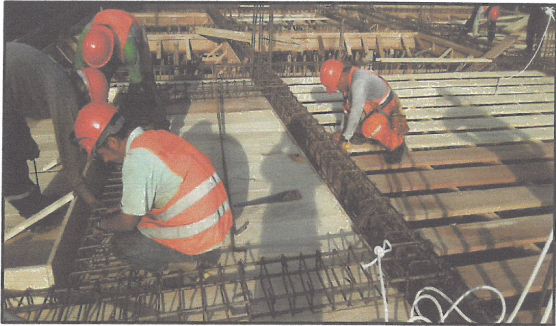
ENCOFRADO DE VIGUETAS EN LOSA ALIGERADA EN CONTINGENCIA.
